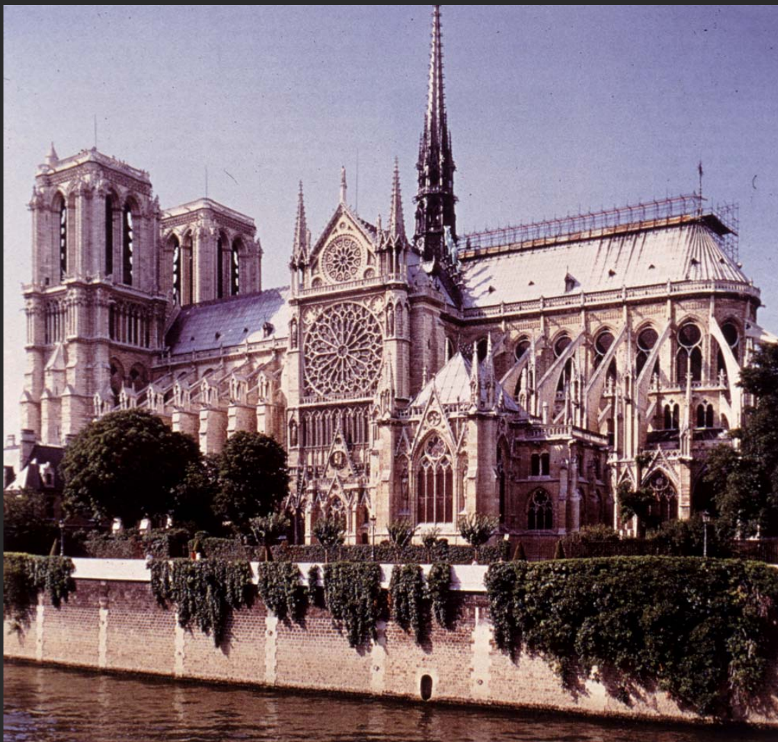
วัดโนเตรอดามแห่งปารีส ( Notre-Dame of Paris ) ค.ศ.1163 — 1200 สร้างโดยบิชอปอูว์ดส์ เดอ ซุลลี ( Eudes de Sully ) มีเสาค้ำยันภายนอกอาคาร ( Flying buttress )
