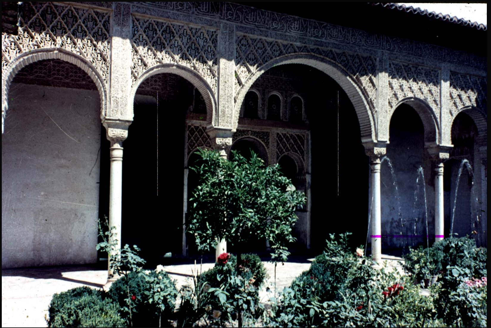
สถาปัตยกรรมรูปเกือกม้า ที่ Granada สเปน
