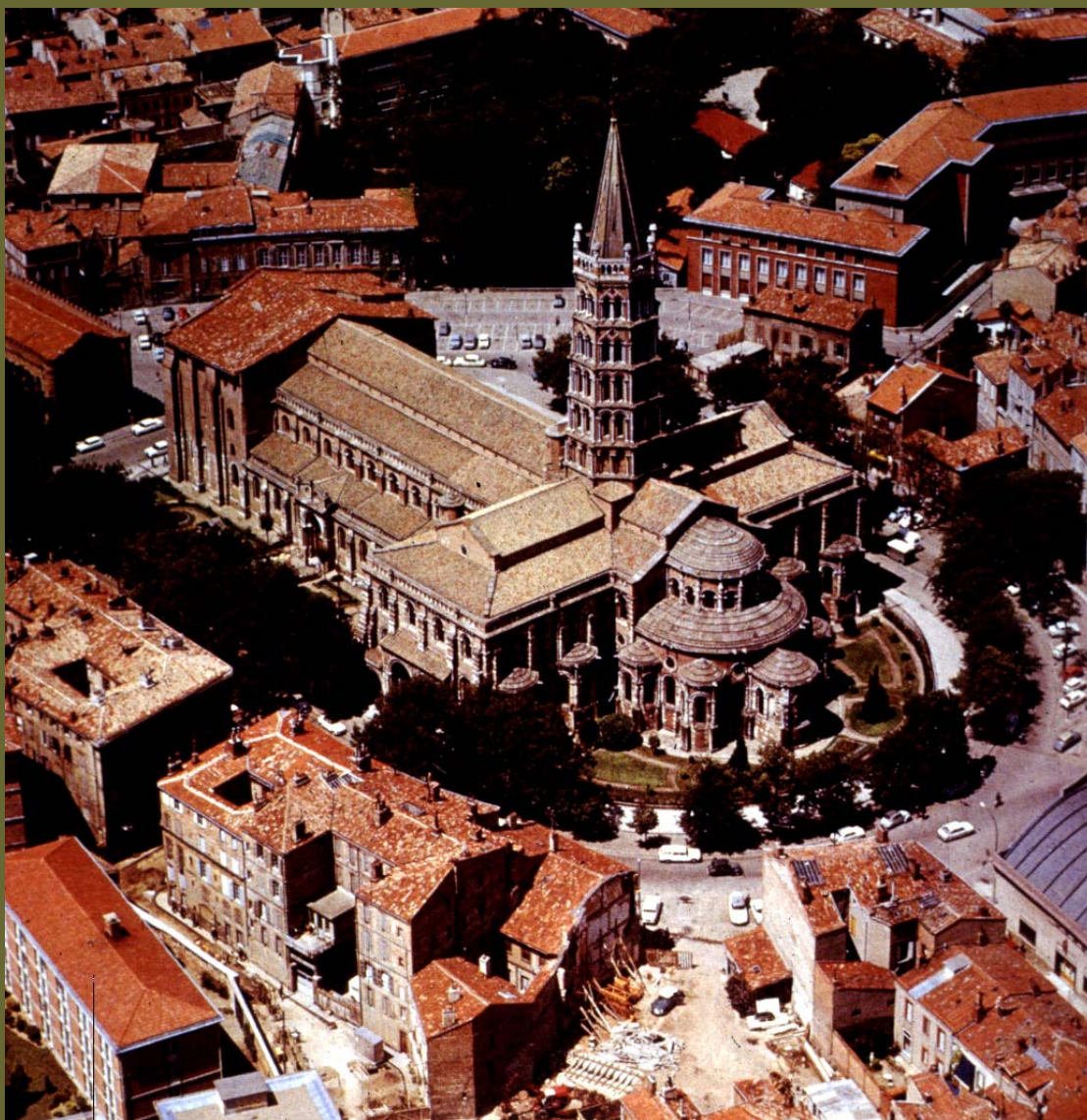
วัด แซงต์ แซร์แนง (Saint Sernin) เมืองตูลูส ฝรั่งเศส ค.ศ.1080 – 1120 หอคอยสูง 215 ฟุต
