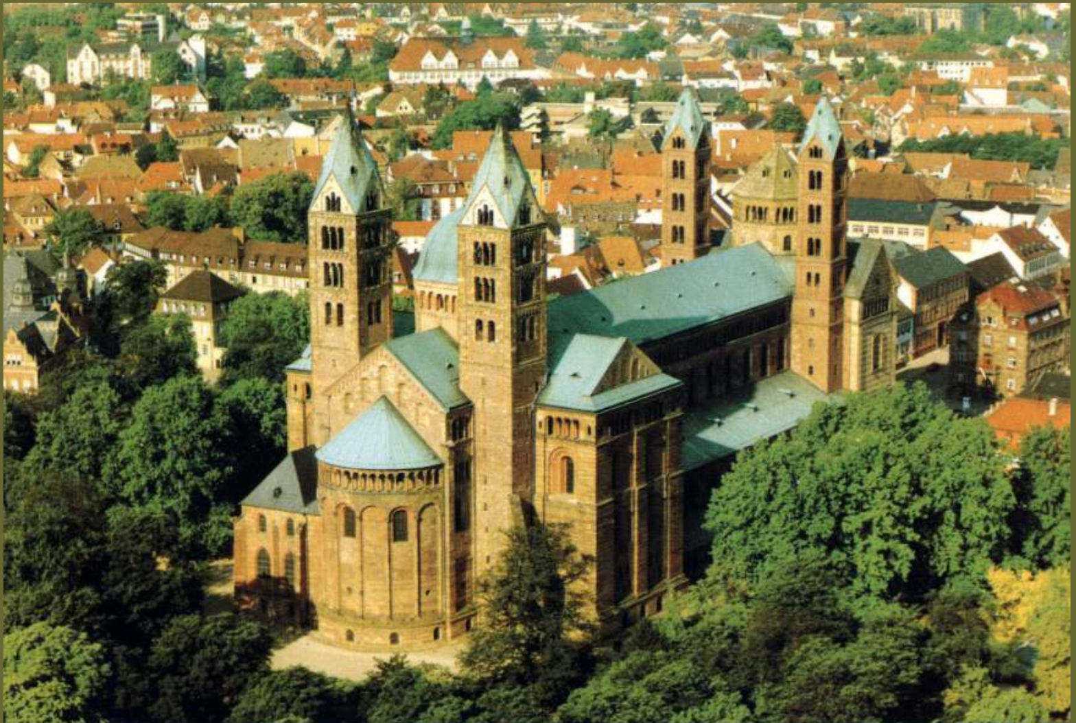
วัดสเปเยอร์ หลังคาหลังเดิมสร้างด้วยไม้ (ค.ศ.1030) แต่เปลี่ยนเป็น หิน และทำเป็นเพดานโค้ง
