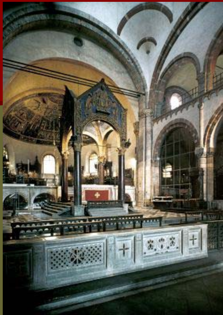
ภายในวัด ซานต์ แอมโบรจิโอ โครงสร้างหลังคา ใช้โวลท์สลับไขว้
