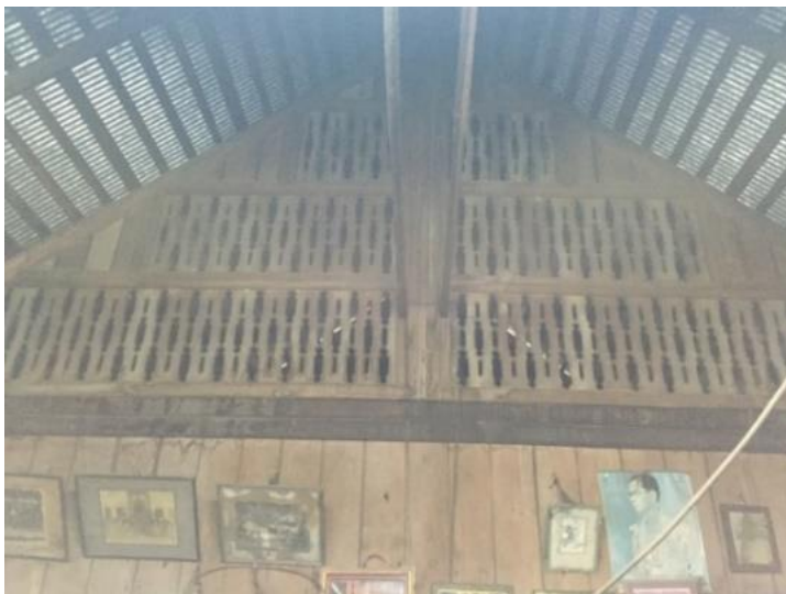
“แผงแผงมู่ก้าง” หรือแผงจั่วกันห้องนอนและห้องพักผ่อนภายใน
