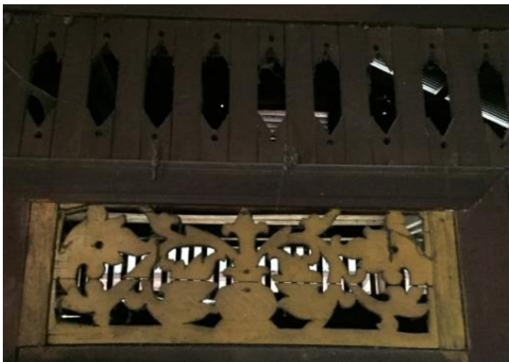
แผงคอลายและแป้นฉลุลายรูปหม้อดอก เหนือกรอบประตูทางเข้าห้องนอน
