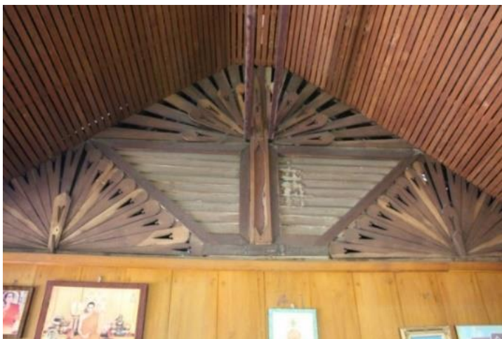
“แมงมู่ก่าง” แผงหน้าจั่วอุดพระหว่างห้อง กางกั้นห้องนอน - ห้องรับแขก
